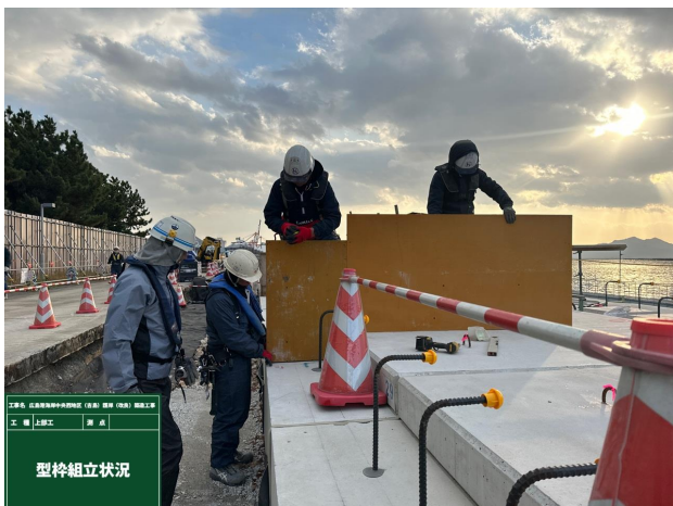
⑤ 上部コンクリート 型枠組立
