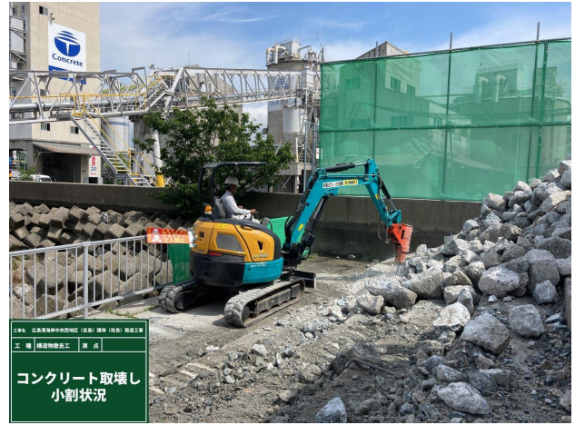
② 構造物撤去
