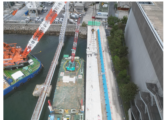
④ 直立消波ブロック据付
