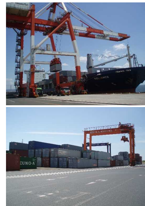
荷役状況写真
