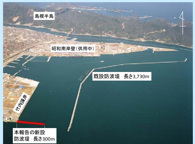
(写真-1) 境港の現況と新設防波堤の位置(H18.5撮影)
