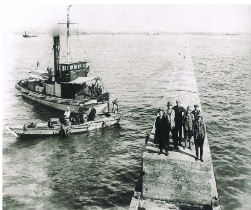
↑ 昭和8年7月31日に完工した沖ノ山南部防波堤(871.2m)／昭和4年4月に着工されたこの防波堤建設によって、宇部港は2,000トン級の鋼船の接岸が可能な大規模な港へと発展しました。
