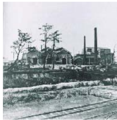
←整備の進む海軍練炭製造所／明治37年に開設され、その後石油の需要が増大したため、さらに施設の拡張整備が行われました。
