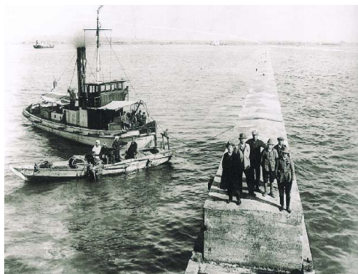
↑昭和8年7月31日に完工した沖ノ山南部防波堤(871.2m)／昭和4年4月に着工されたこの防波堤建設によって、宇部港は2,000トン級の鋼船の接岸が可能な大規模な港へと発展しました。
