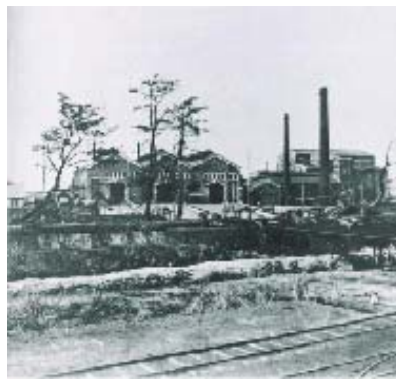
←整備の進む海軍練炭製造所／明治37年に開設され、その後石油の需要が増大したため、さらに施設の拡張整備が行われました。
