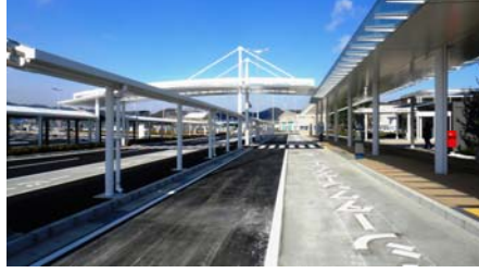
○歩道ルーフ:完成(中国地整)
