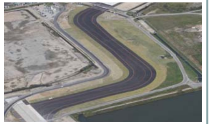
○誘導路:新設舗装完成(中国地整)
