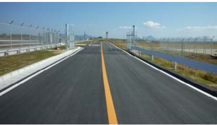
○外周道路:完成(中国地整)
