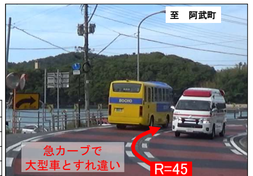
写真③ 線形不良箇所 ・萩市椿東中小畑付近
