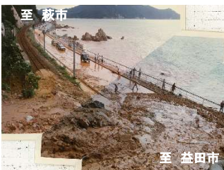
【写真②】S55年土砂崩壊の状況
