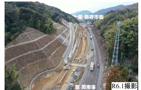
【写真①】樺地区の法面施工状況
