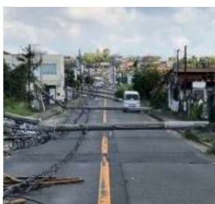
<電柱の倒壊による道路閉塞の事例>
