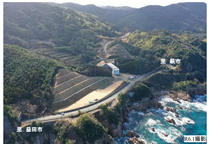
【写真①】 宇田地区の施工状況
