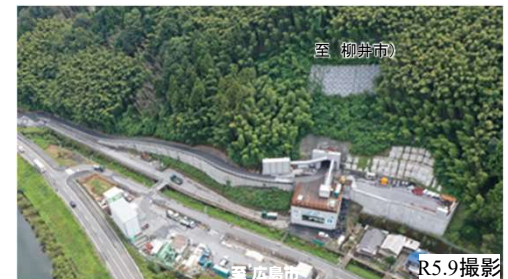
【写真②】和木町(岩国トンネル起点側坑口)の施工状況
