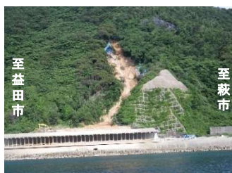
【写真③】H23年土砂崩壊の状況
