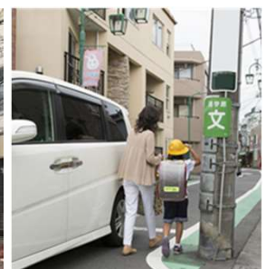
<歩行の支障となる電柱の事例>
