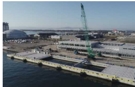
↓PC桁の架設状況(令和元年11月)
