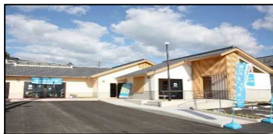
瀬戸内市観光センター 瀬戸内きらり館
