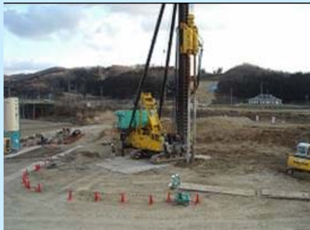
深層混合処理状況写真
