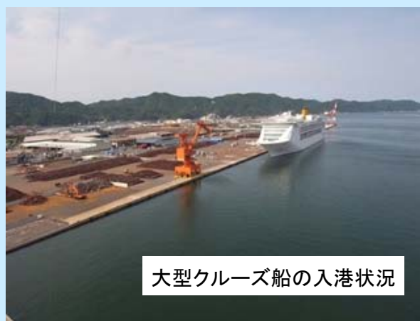
境港での空撮画像
