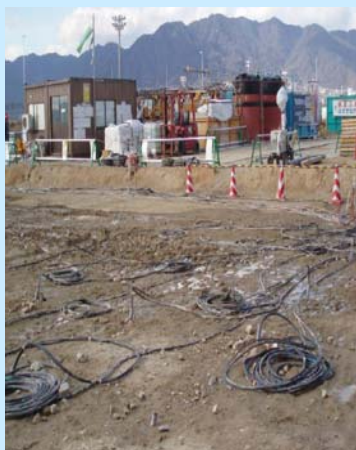
薬液注入状況写真
