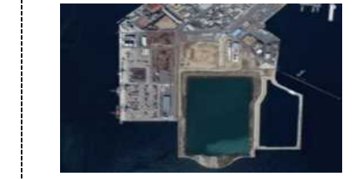
【広島港出島地区処分場】
