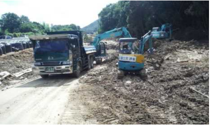
【被災地からの土砂等搬出状況】
